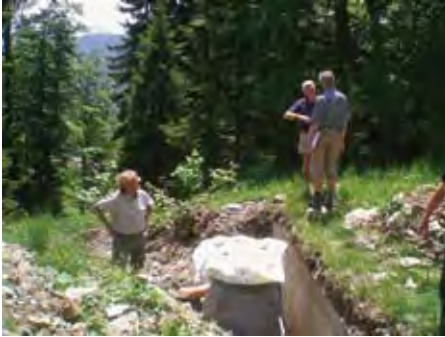
Fertigstellung der Abwasserversorgung
