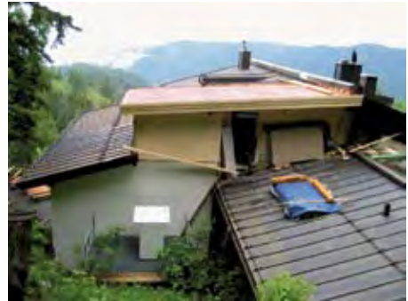
Ausbau einer Dachgaube im 2. Stock
